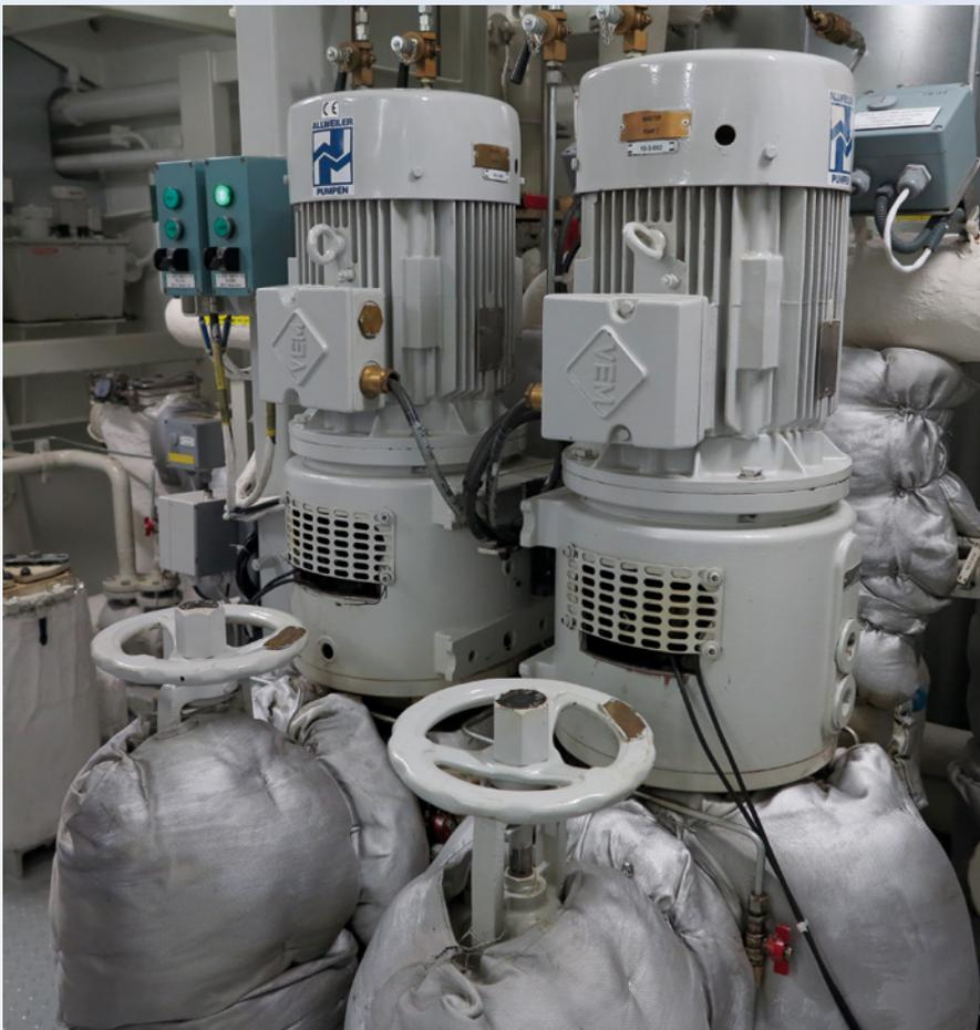
Vertikale Schraubenspindelpumpen werden als Boosterpumpen für unterschiedliche Brennstoffqualitäten eingesetzt.
