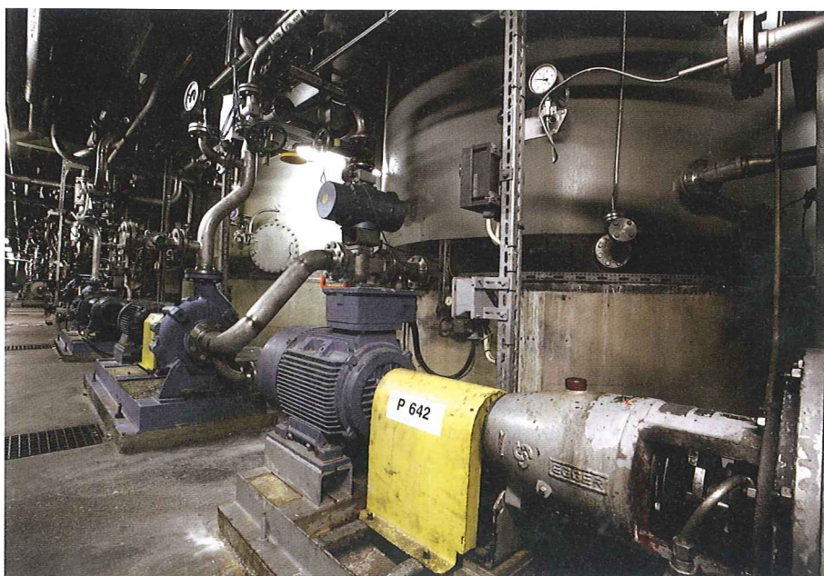
Bild 1: Typisches Tanklager mit Umfüllpumpen
