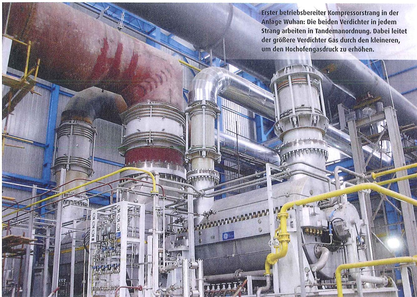
Erster betriebsbereiter Kompressorstrang in der Anlage Wuhan: Die beiden Verdichter in jedem Strang arbeiten in Tandemanordnung. Dabei leitet der größere Verdichter Gas durch den kleineren, um den Hochofengasdruck zu erhöhen.
